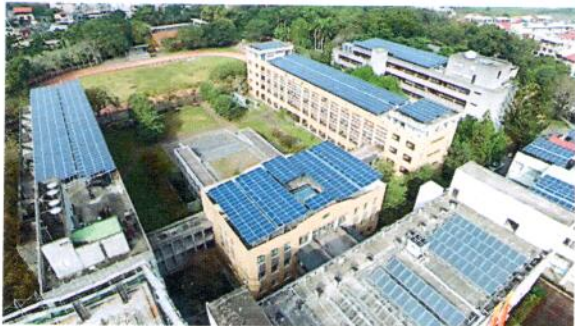
透過空拍攝影，暨大附中頂樓的藍色太陽能板，由建築對稱呈列，十分壯觀。(圖：暨大附中提供)
